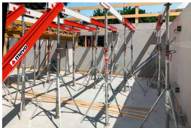
Deutlich weniger Stützen und mehr Bewegungsfreiheit. Integrierte Aufnahme-dorne ersetzen Trägergabeln und -krallen. Dreibeine dienen zur weiteren Sicherung der Stützen.
