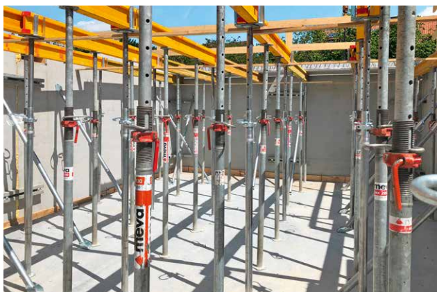
Enger Stützenabstand: Deutlich mehr Aufwand für das Stellen der vielen Stützen.
